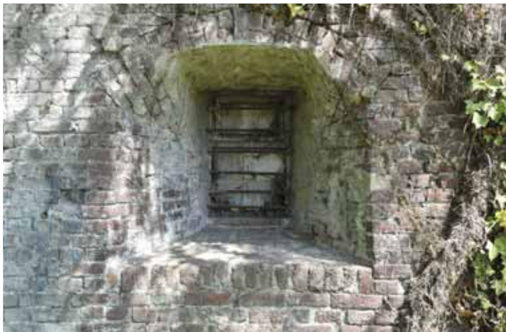
Fig. 30. Menen, Hollands bastion nr. 11, toestand op 9 mei 2022. Vrijgelegde geschutskamer in de westflank van het bastion.
