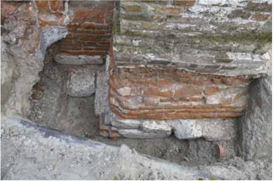
Fig. 42. Vichte, Sint-Stephanus- en Sint-Diederikskerk, opgraving Monument Vandekerckhove 2022. Gezicht op een pijler van de noordbeuk, uitgewerkt met baksteen en witte, krijthoudende kalksteen (Monument Vandekerckhove).
