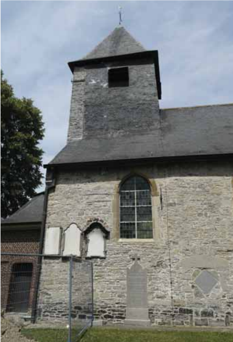
Fig. 39. Vichte, Sint-Stephanus- en Sint-Diederikskerk. In de opbouw van de toren is aan westzijde de natuurstenen klokkengevel zichtbaar.
