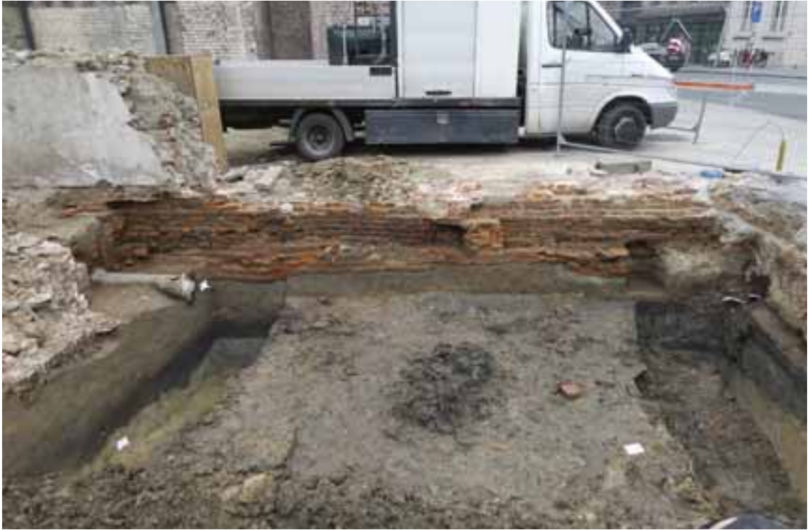
Fig. 13. Kortrijk, Overleiestraat 62-64. Bakstenen fundering, aangezet op een drassig, met afwaterkanaaltjes doorsneden terrein (Mon. Vandekerckhove).
