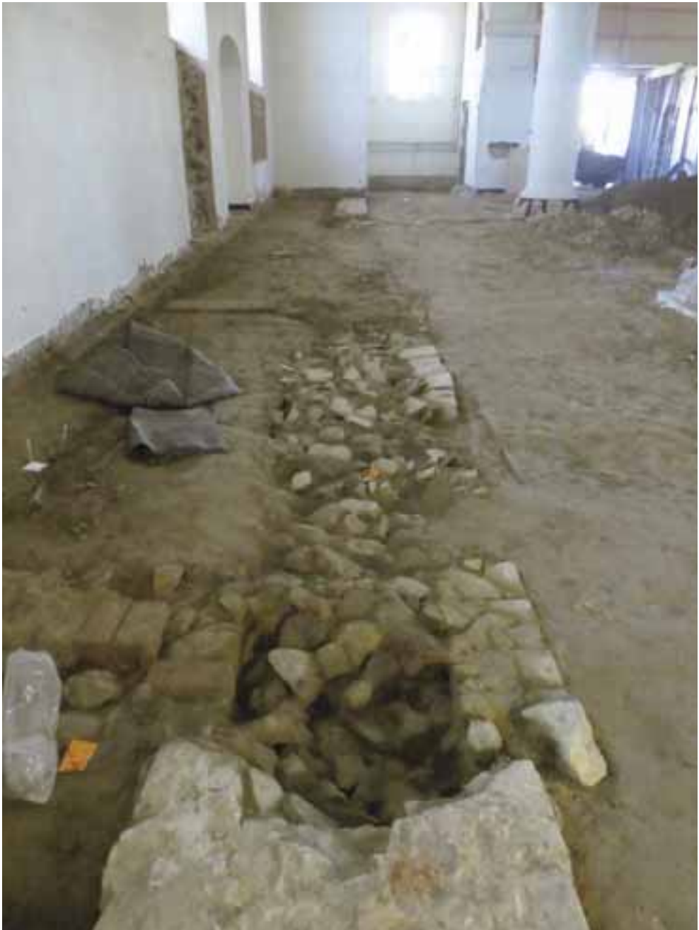
Fig. 2. Aalbeke Sint-Corneliuskerk: jongere verbouwingen en aanbouwsel in en aan de zuidelijke Romaanse beuk, herkenbaar in de vrijgelegde fundering.
